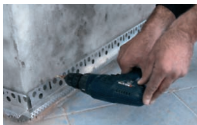
Извършване на монтаж със специални дюбели
